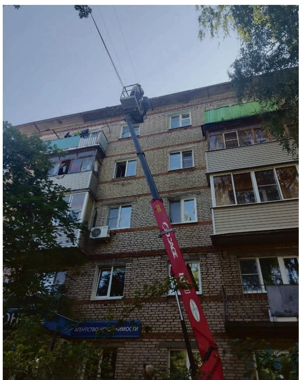
так стихия и подкидывает внеплановые задачи. Только в июле кровельщики заменили 120 листов шифера, загерметизировали 180 метров примыкания вентиляционных каналов, фановых труб и металлических свесов, закрыли гидроизоляционным материалом в общей
